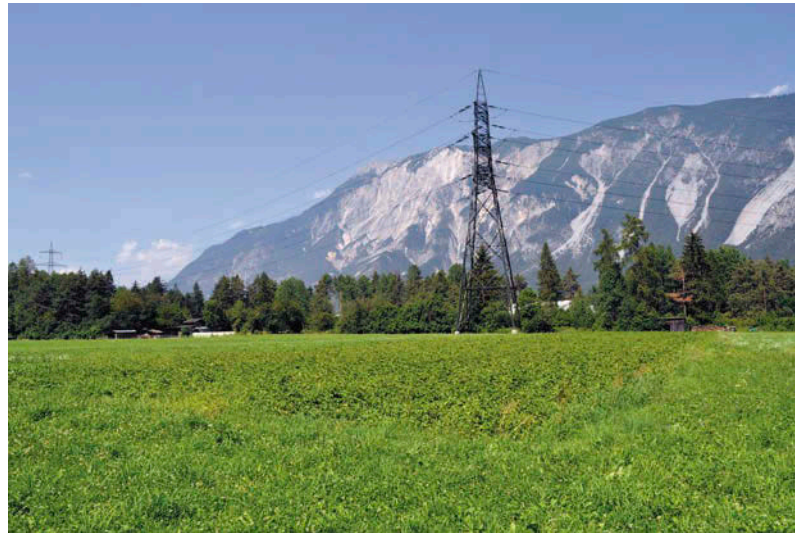
Südlich der Bundesstraße stehen auf dem circa 450 Meter langen und 200 Meter breiten Grundstück die vier Strommasten, die nächstes Jahr entweder versetzt oder erhöht werden.
